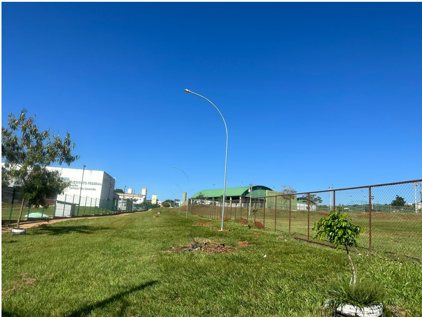
Figura 02: Ampliação da Iluminação Pública entre IFB/Ginásio de Esportes no bairro São Bartolomeu, no Núcleo Urbano de São Sebastião - DF.
