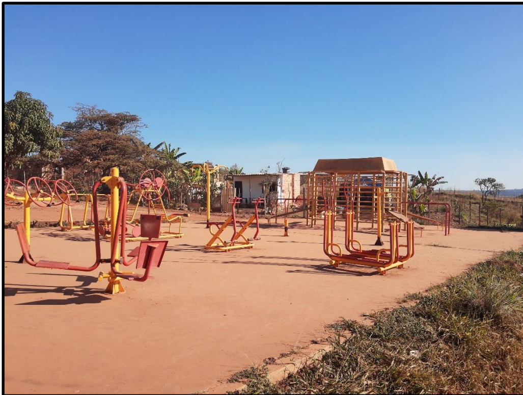
FOTO 04 – FOTO DO ESTADO ATUAL DOS EQUIPAMENTOS DE P.E.C.
