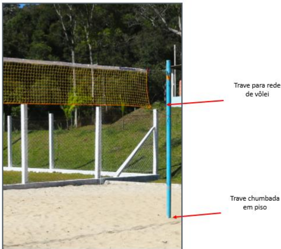
IMAGEM 09 – DETALHE DE HASTE FIXADA PARA REDE DE VÔLEI
